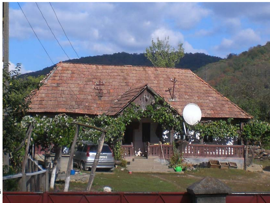
foto 21. Casă tradițională cu șarpantă abruptă și târnaț cu parapet și fronton de lemn traforat.
