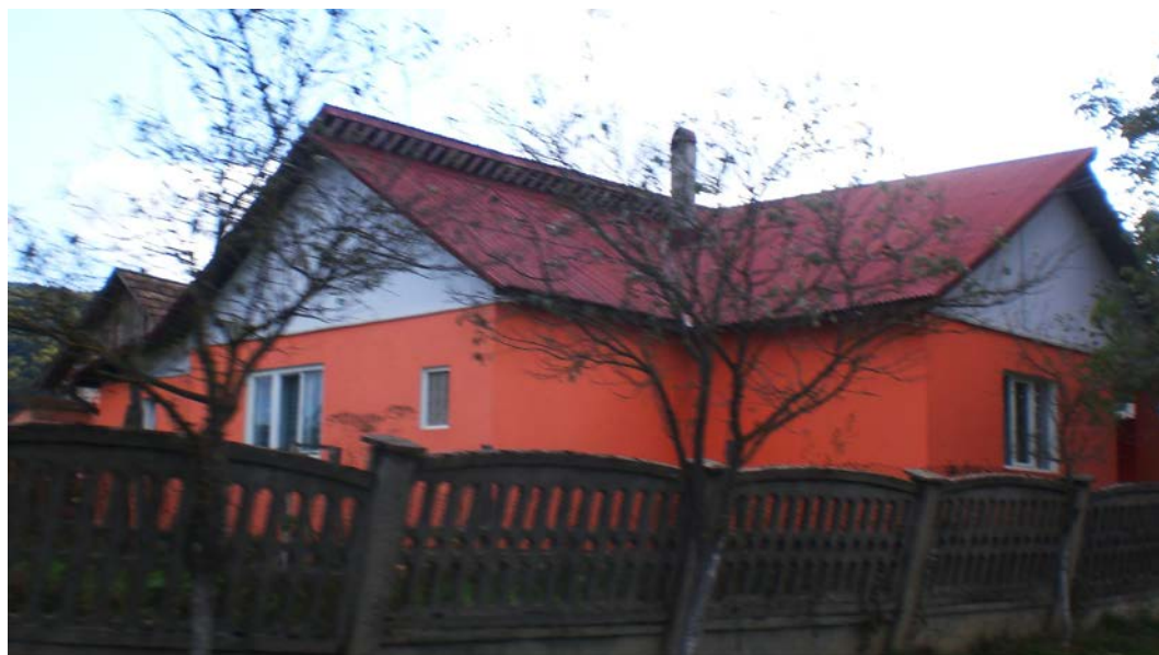
foto 25. Casă nouă, cu forme, materiale și culori inadecvate contextului: șarpantă cu ape suprapuse, învelitoare bituminoasă, finisaj în culoare puternică, timpane drepte care fac ca volumul construit să pară masiv.
