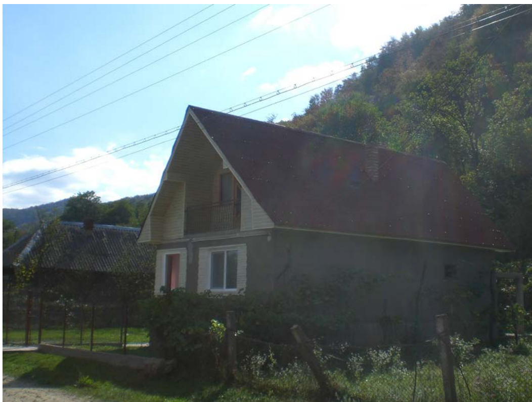
foto 20. Casă construită în perioada comunistă și mansardată recent. Volumul rezultat în urma intervenției respectă volumetria tradițională, se înscrie corect în sit și are o relație bună cu mediul și vecinătățile; ocuparea tradițională a parcelei se menține. Din păcate, s-au utilizat materiale nespecifice zonei- învelitori bituminoase, placaje din PVC. Totuși, este un exemplu bun de respectare a cadrului construit tradițional.
