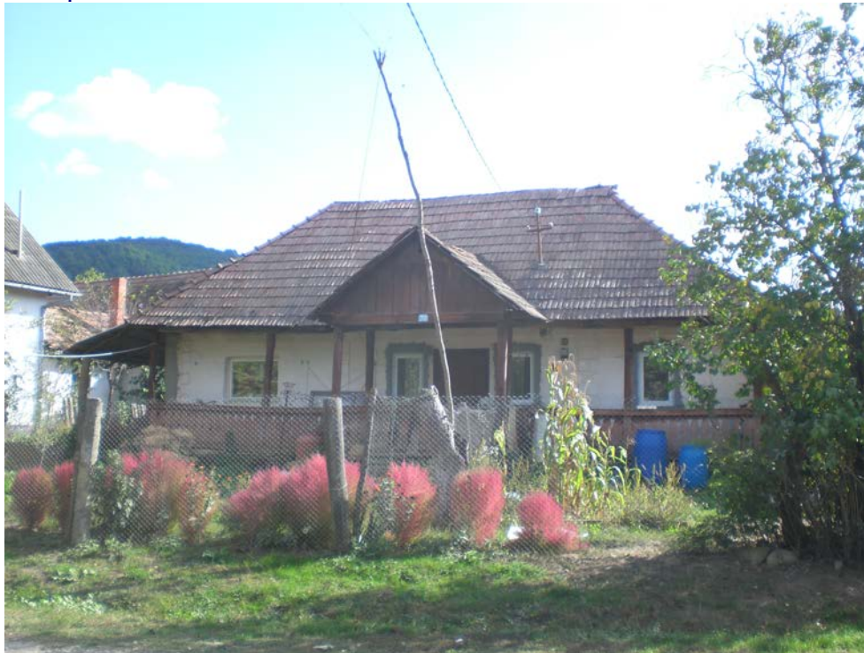
foto 12. Subtip 4- casa cu târnaț cu parapet pe toată lungimea clădirii și cu foișor central- casă din Fodora.
