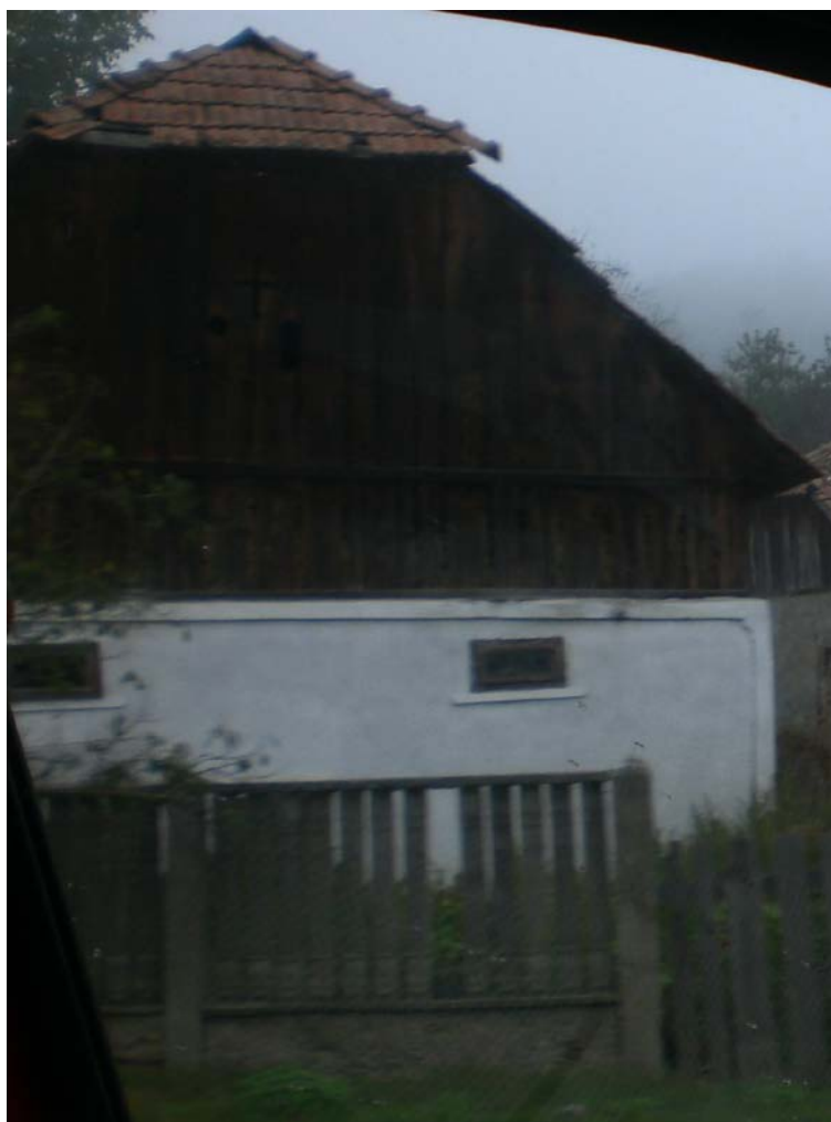
foto 15. șură tradițională cu timpan teșit din lemn
