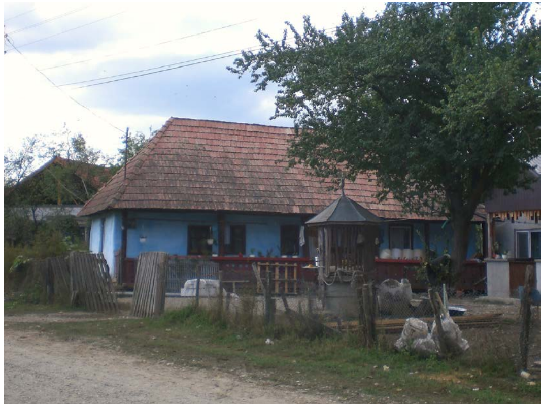
foto 20. Casă tradițională cu șarpantă abruptă și târnaț cu parapet de lemn traforat.
