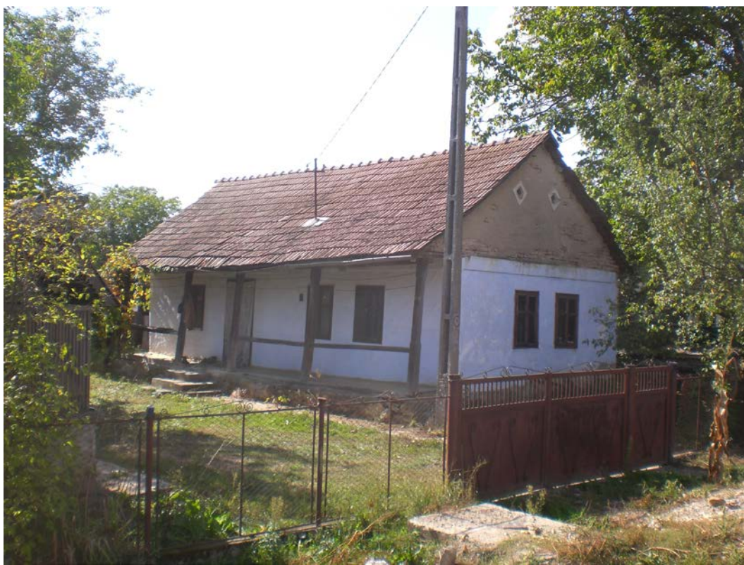
foto 16. casă tradițională cu târnaț în Bârsău Mare
