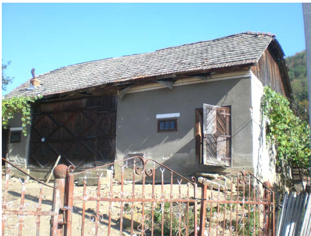
foto 8. Șură tradițională cu timpan teșit, ușă și poartă din lemn. Se observă frumusețea ușii și porților dulgherești.
