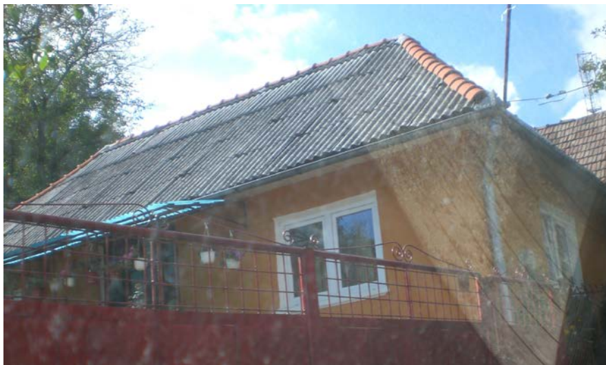
foto 19. Casă construită în perioada comunistă și renovată recent, în culori puternice, atipice arhitecturii locale. Totuși, se menține volumetria inițială, casa rămânând bine integrată în sit.
