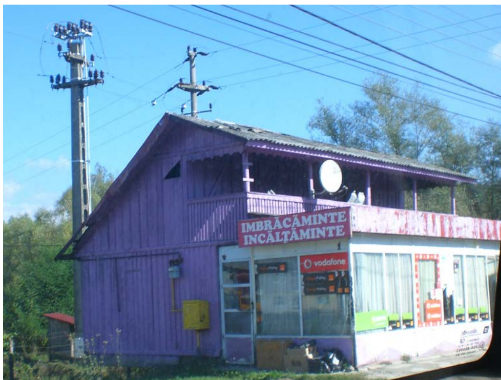
foto 19. spațiu comercial cu forme străine tradiției locale și culoare inadecvată.
