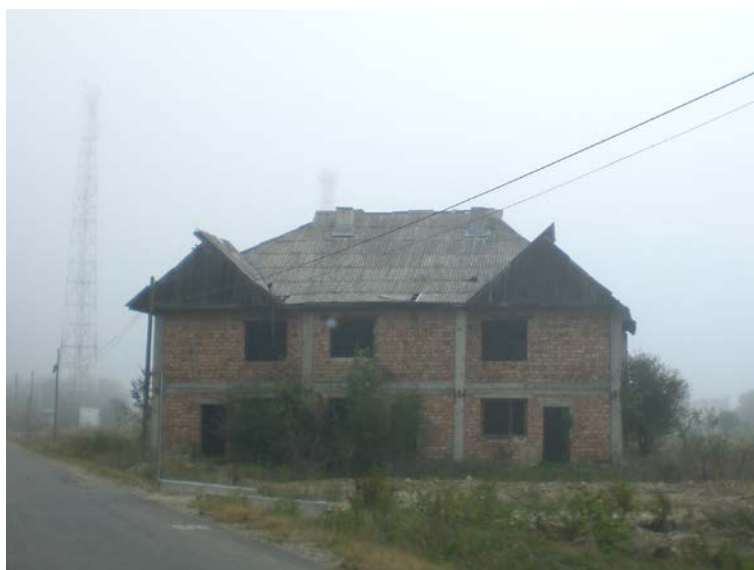
foto 22. Casă abandonată în timpul construirii, cu volume și forme străine arhitecturii locale. Sunt nepotrivite volumul masiv, acoperișul cu lucarne laterale, învelitoarea din plăci de azbociment.
