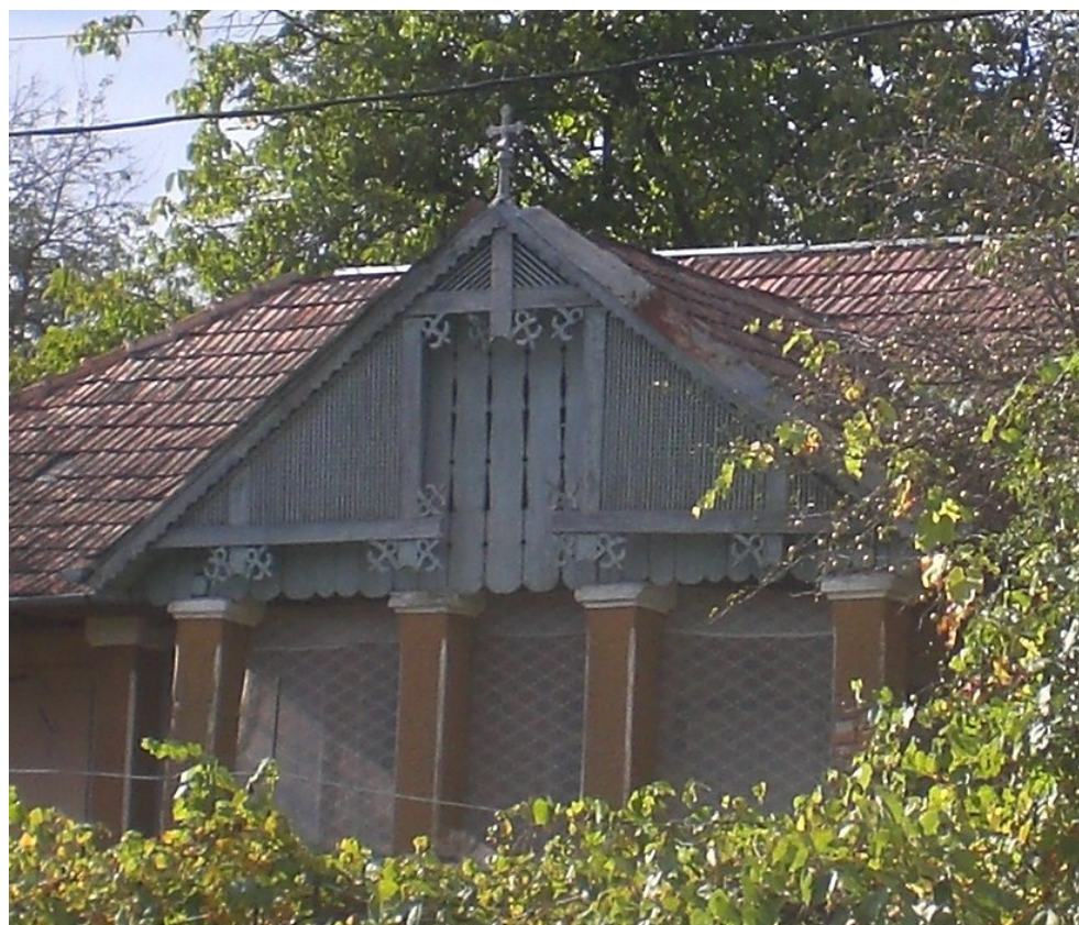
foto 18- conacul de la Dobrocina- detaliu de trafor pe timpan. Se observă decorațiunea minuțioasă, cu detalii complicate.
