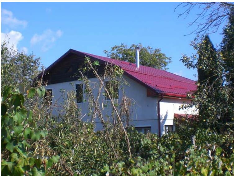
foto 21. Casă nouă, cu volume și forme străine arhitecturii locale. Sunt nepotrivite volumul masiv, timpanul drept, acoperișul frânt, învelitoarea din tablă
