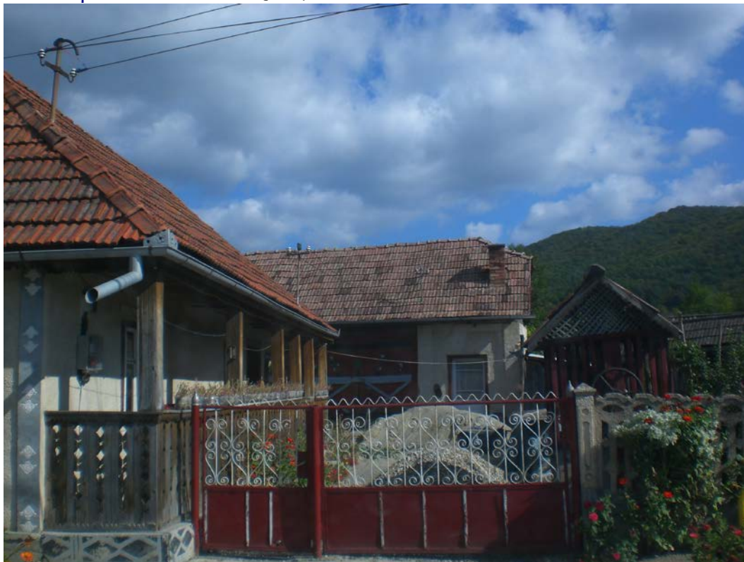
foto 13. Gospodărie cu conformare tradițională în Glod: șură cu timpan teșit; casă cu târnaț, cu parapet traforat
